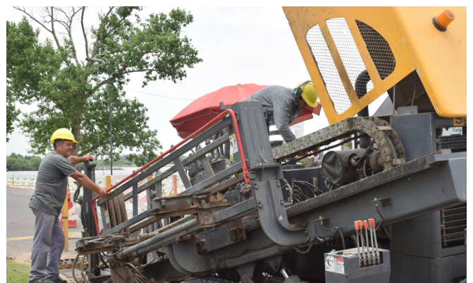
Sistema de tunelera inteligente, metodología elegida para esta obra. Pasará los cables de media tensión (protegidos y normalizados) a 1.50 metros de profundidad haciéndolo más seguro y protegiéndolo de posibles excavaciones.
